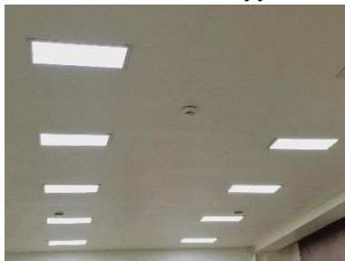
Зохиомон гэрэлтүүлэг /Агуулахад 380, лабораторийн өрөөнд 300 люкс/
