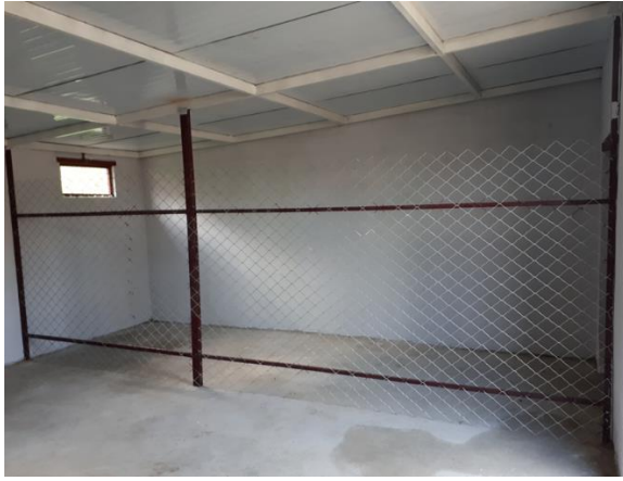
Зураг 1. 10. Хог ялгах байрны дотор торон хана хийсэн байдал
