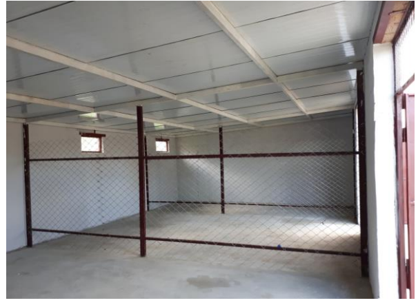
Зураг 1. 10. Хог ялгах байрны дотор торон хана хийсэн байдал
