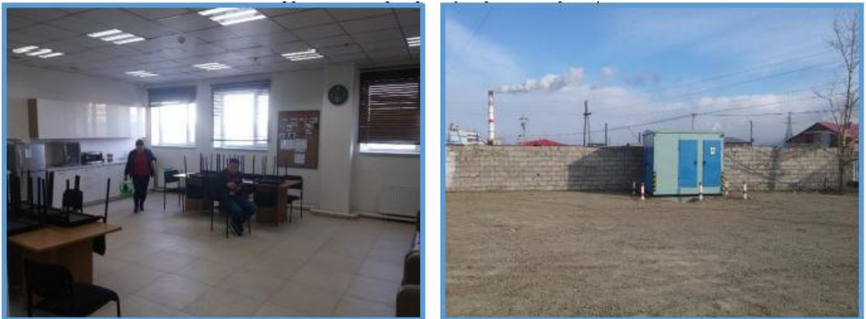
Зураг 19. Амралтын өрөө ба Цахилгааны дэд станц
