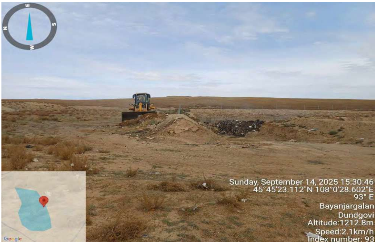
Зураг №13 2025 оны 09 сарын 14-ны өдөр нөхөн сэргээлт хийж буй байдал
