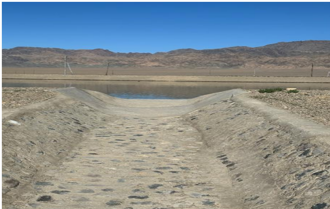
Зураг 2. 21000 куб метрийн доторлогоотой усан ангийн ажил бүрэн дуусч ус хуримтлуулж эхэлсэн
