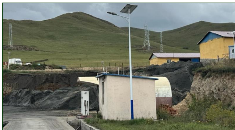
Зураг 12. Үйлдвэрийн хашаан дахь дизель түлшний нөөцийн агуулах, түгээх хэсэг
