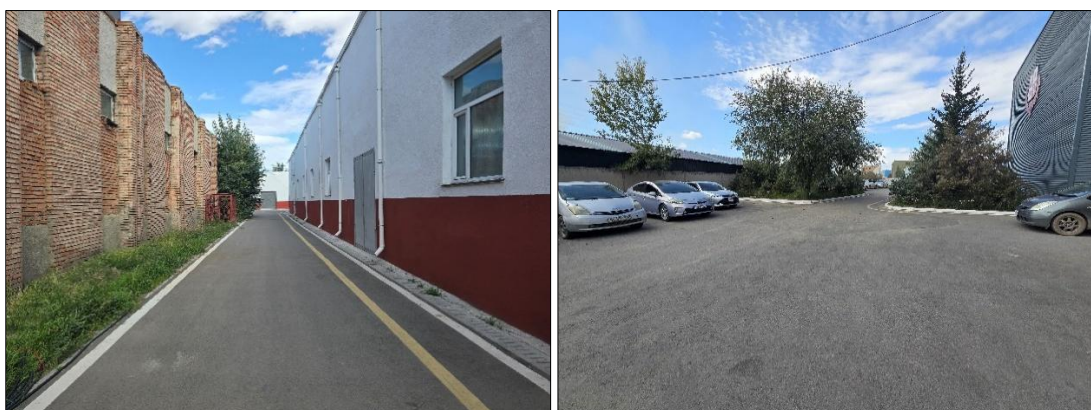
Зураг 12. Үйлдвэрийн дотоод зам талбай
