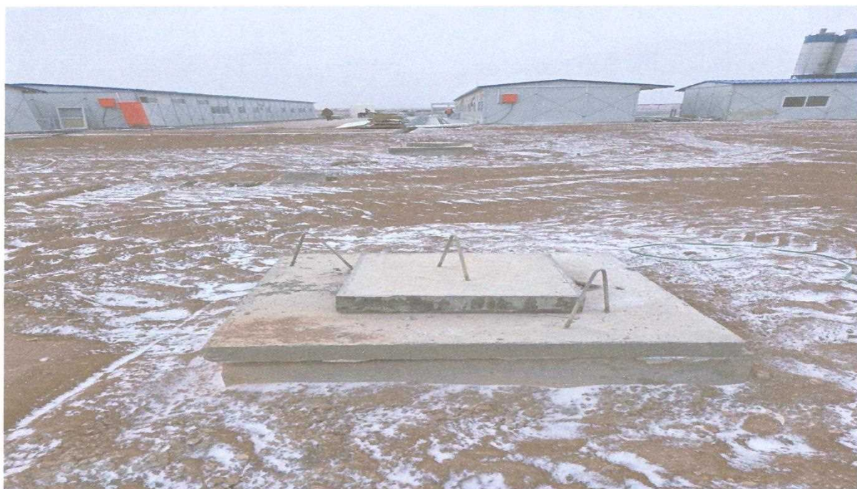
Хавсралт зураг 8. Бохир ус хуримтлуулах юмкостын газар дээрх тагны битүүлэл
