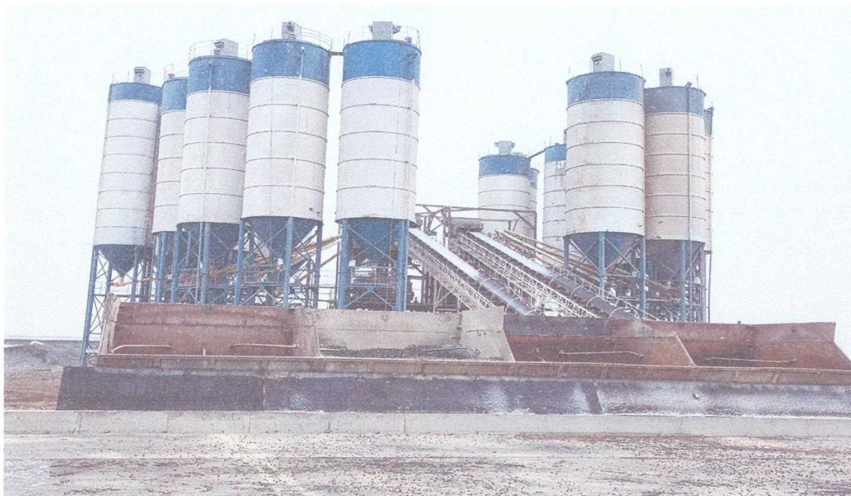
Зураг 7. Бетон хольцийн үйлдвэр угсралтын ажил./2025.10.18/
