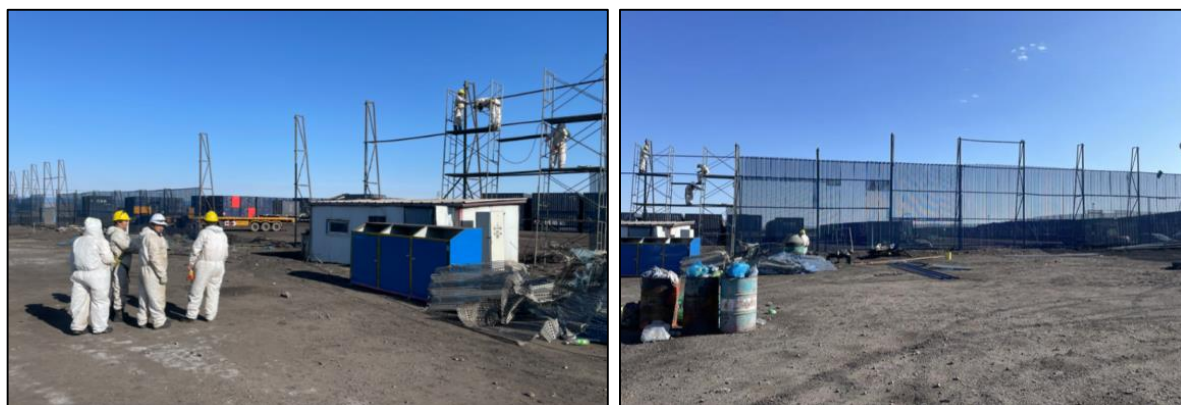
Зураг № 7. Салхины хаалт нөхөн засварлаж буй байдлын тухай зураг
