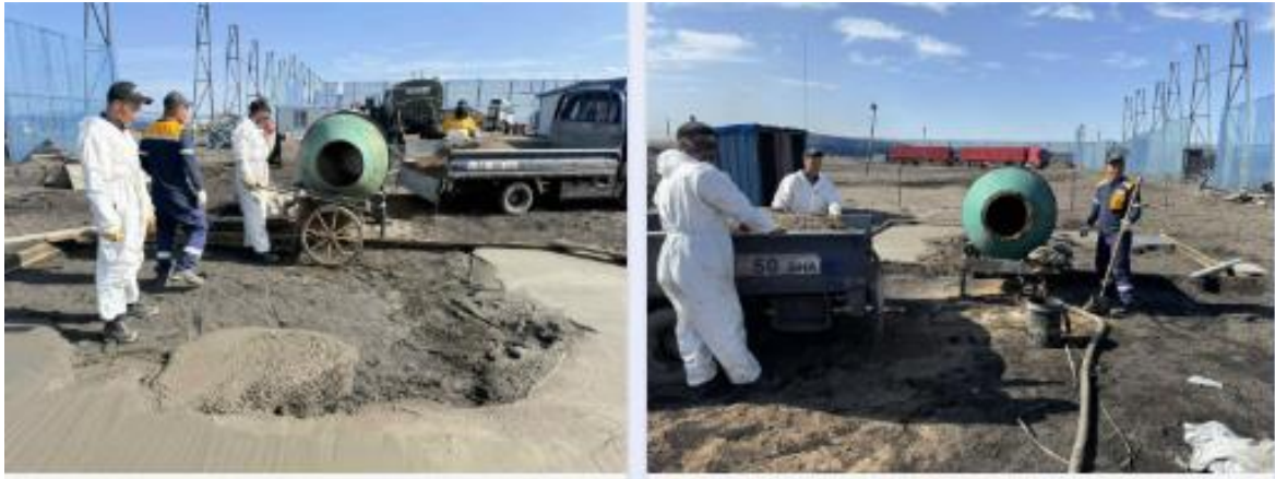
Зураг № 28. Хог хаягдлын цэгийн суурийг бетондож буй байдал
