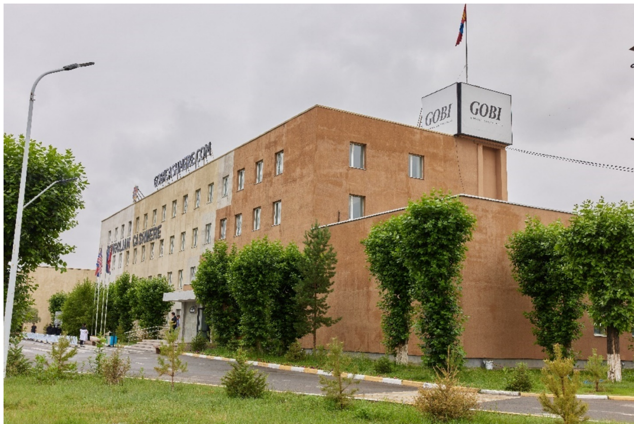
Зураг.2 Говь ХК-ийн үйлдвэрийн байр
