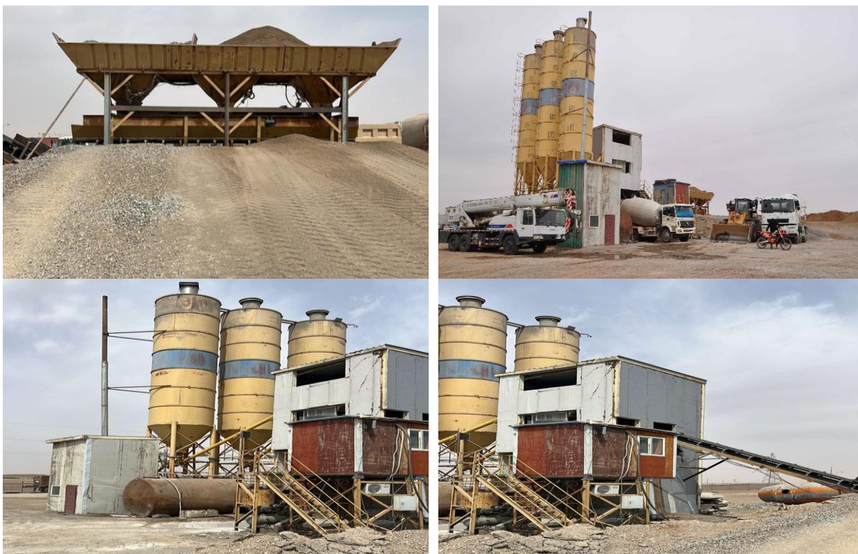
Зураг 4. Төслийн талбайн фото зураг
