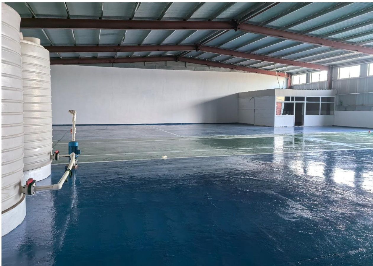
Зураг 8 Үйлдвэрийн хэсэг засвар хийж байгаа байдал
