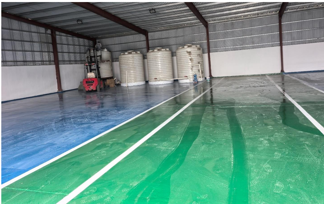
Зураг 7 Үйлдвэрийн хэсэг засвар хийж байгаа байдал
