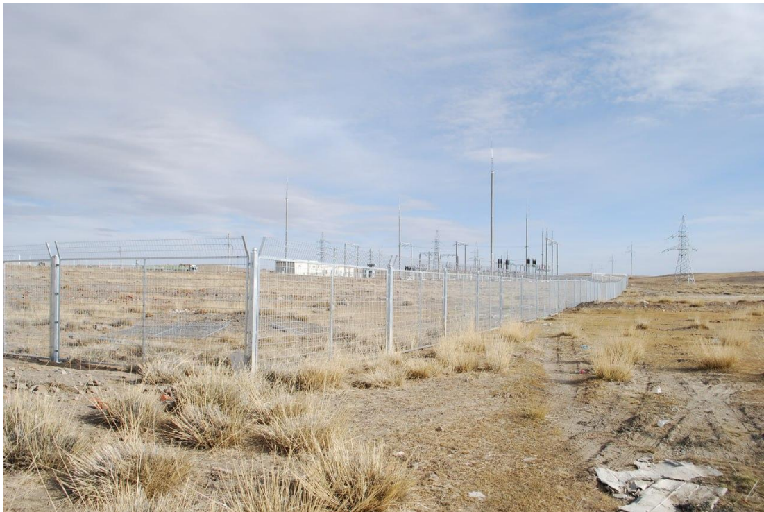
Зураг 4. Төслийн талбайн байдал, 2024-10-10
