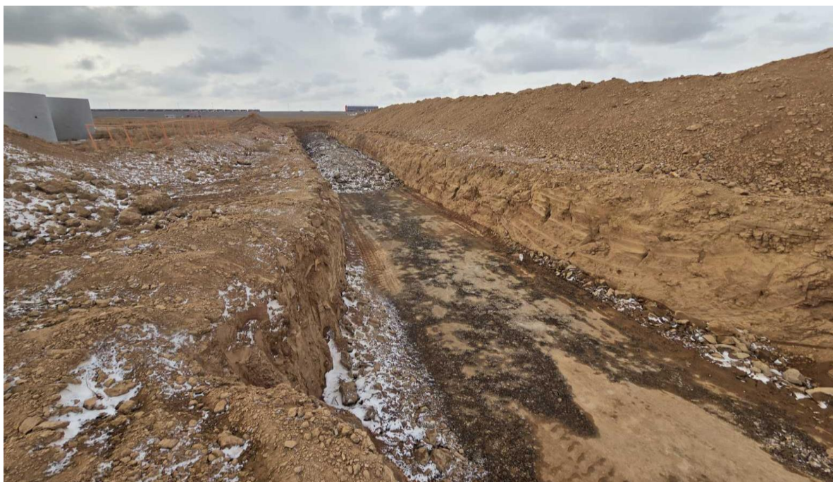
Зураг 11. Төмөр замын доод бүтцийн дугуй болон дөрвөлжин хоолойн суурийн ухмал
