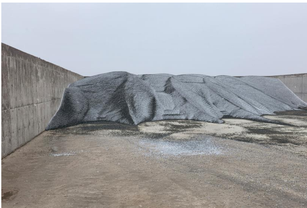
Зураг 9. Бетон дүүргэгч материалын агуулахын суурь барилгын ажлын явц/2025.10.18/
