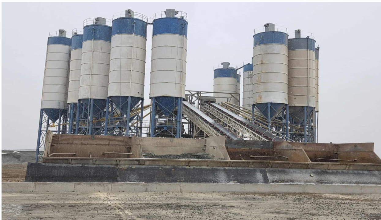
Зураг 7. Бетон хольцийн үйлдвэр угсралтын ажил./2025.10.18/
