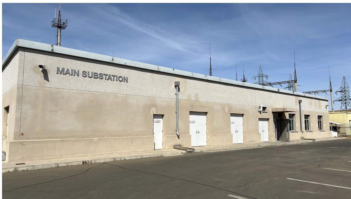
Зураг 1-3. Цахилгааны барилга
