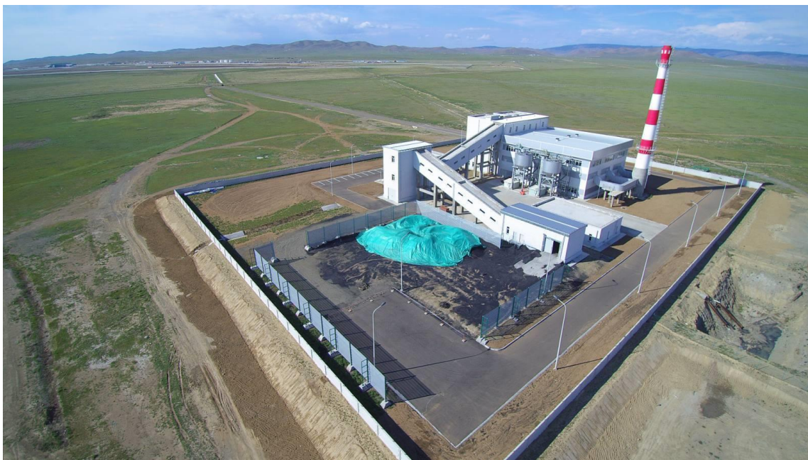
Зураг 1-5. Дулааны станц
