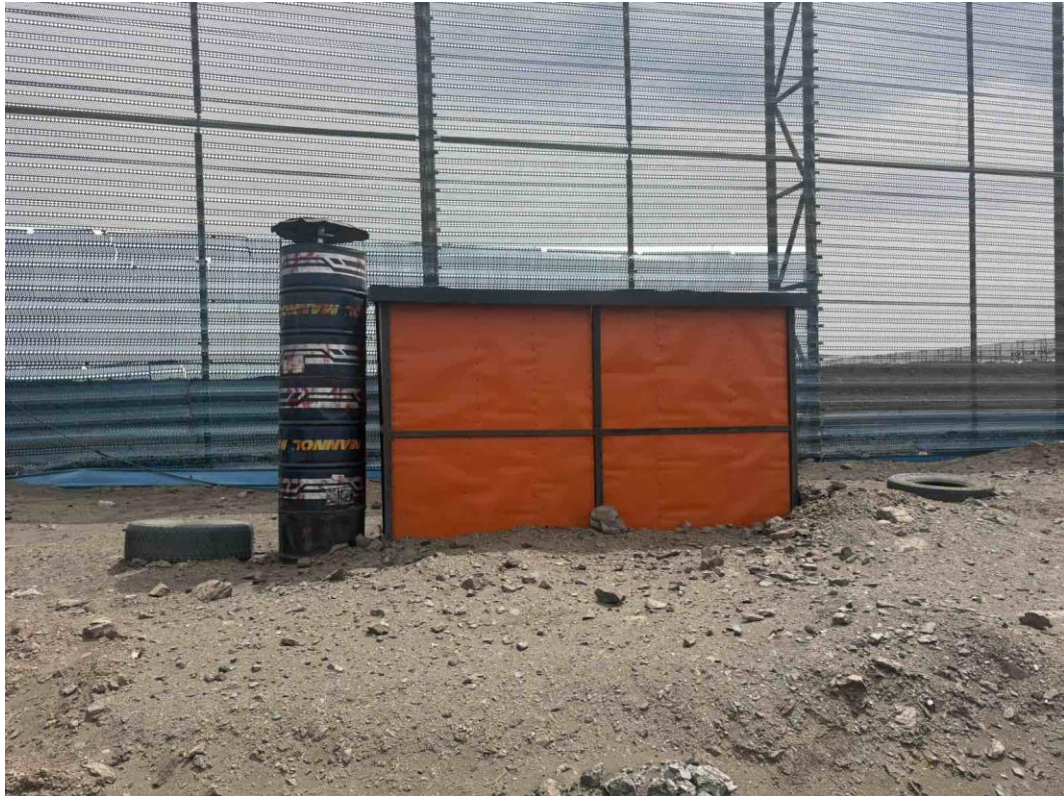
Зураг 22 Гадаах нойл-хойд талаасаа /бетонон кольцо суурилуулсан/
