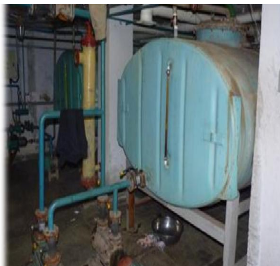
Үйлдвэрийн эргэлтийн усны сав, багтаамж - 200 м 3
