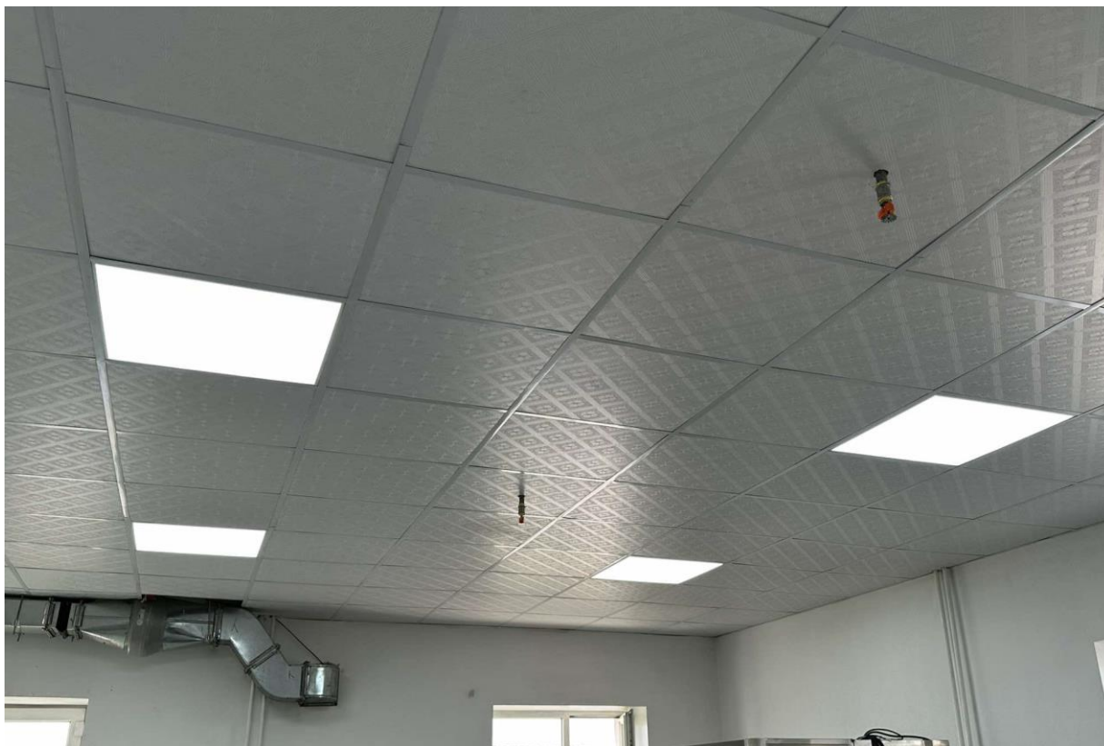
Зураг 14 Үйлдвэрийн гал унтраах систем
