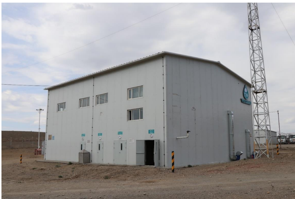
Зураг 2 Хольцын үйлдвэр
