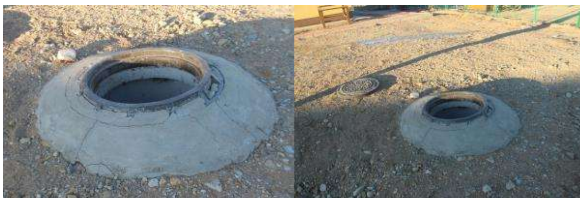
Зураг 15. Бохирын цооног байгуулсан байдал
