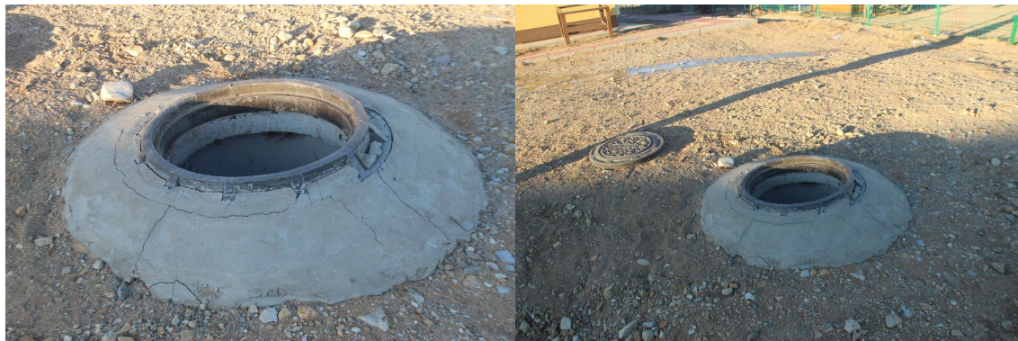
Зураг 18. Бохирын цооног байгуулсан байдал
