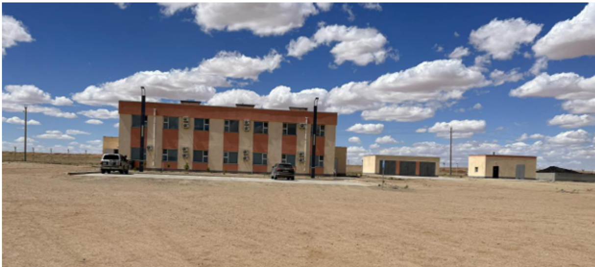
Зураг-16. Оффис болон ажилчдын байр, гал тогоо.
