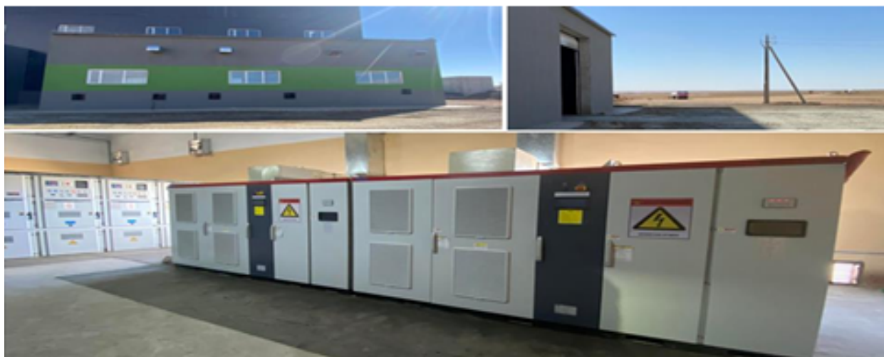
Зураг-14. Баяжуулах үйлдвэрийн 10/04 кВа дэд станц.
