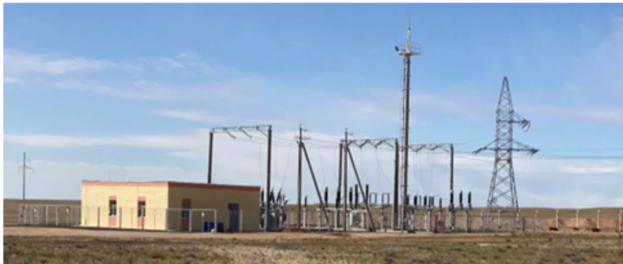
Зураг-14. Баяжуулах үйлдвэрийн 10/04 кВа дэд станц.
