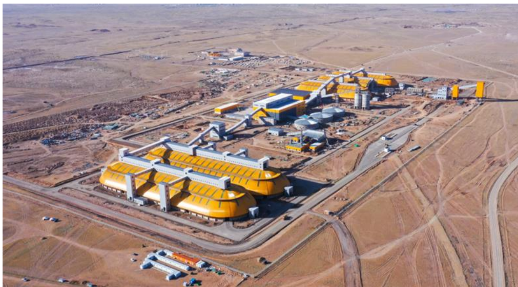
Зураг № 1. "Нүүрс баяжуулах үйлдвэр"-ийн харагдах байдал
