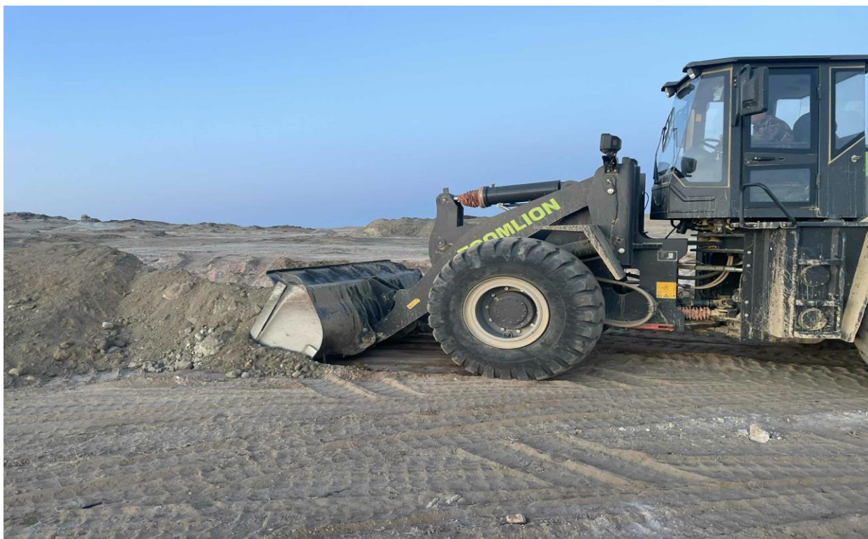
Зураг 10. Нөхөн сэргээлт хийж буй байдал
