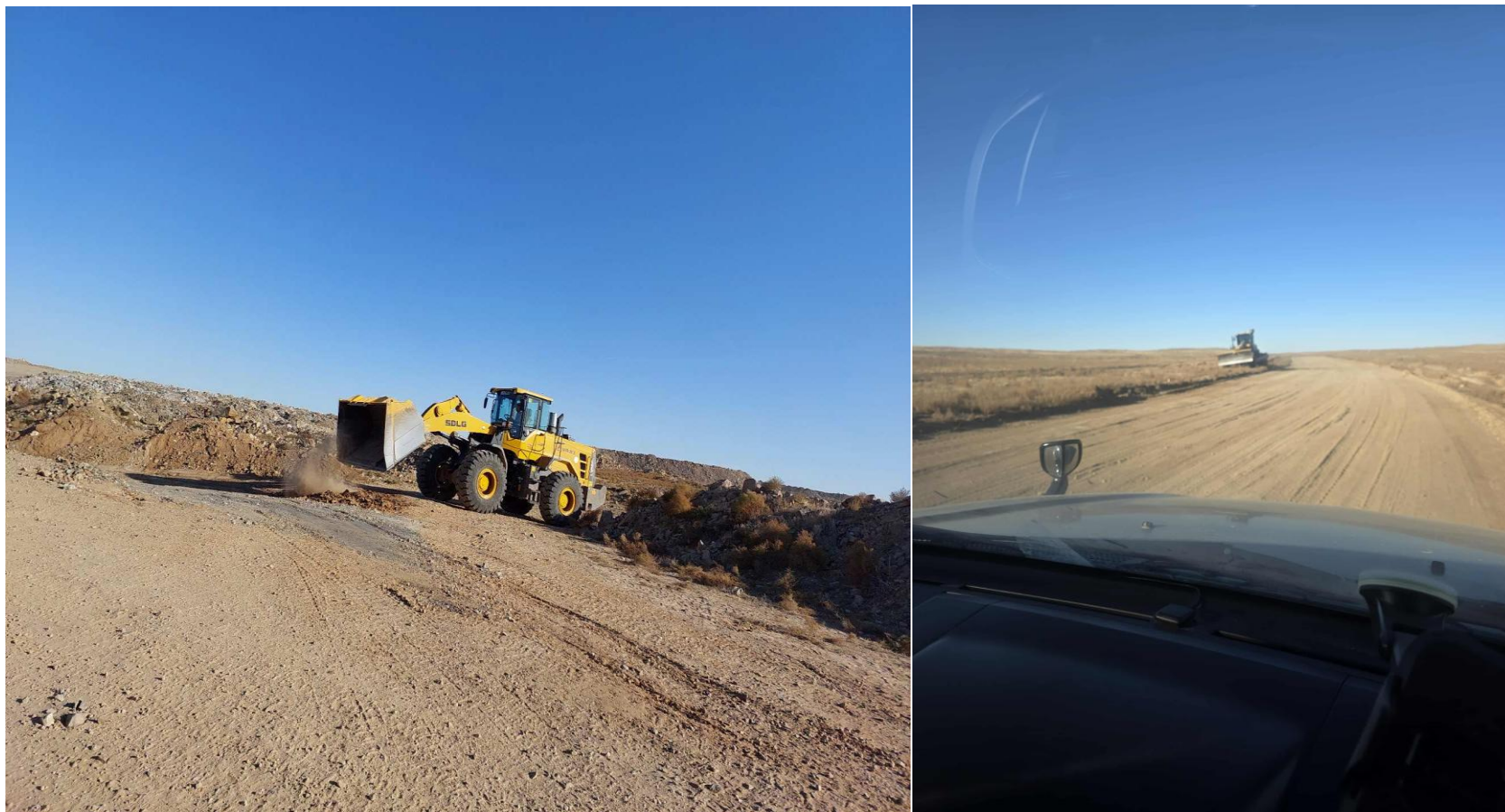
Зураг 2. Уурхайн дотоод тээвэрлэлтийн замуудыг засаж сайжруулж буй үеийн зураг
