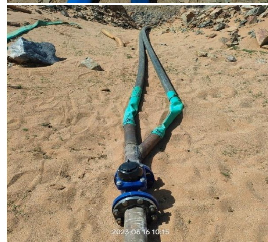
Зураг 8. Уурхайн 1 болон 5-р хүдрийн биетээс гарсан шүүрлийн усанд 2 ширхэг тоолуур байршуулсан байдал.
