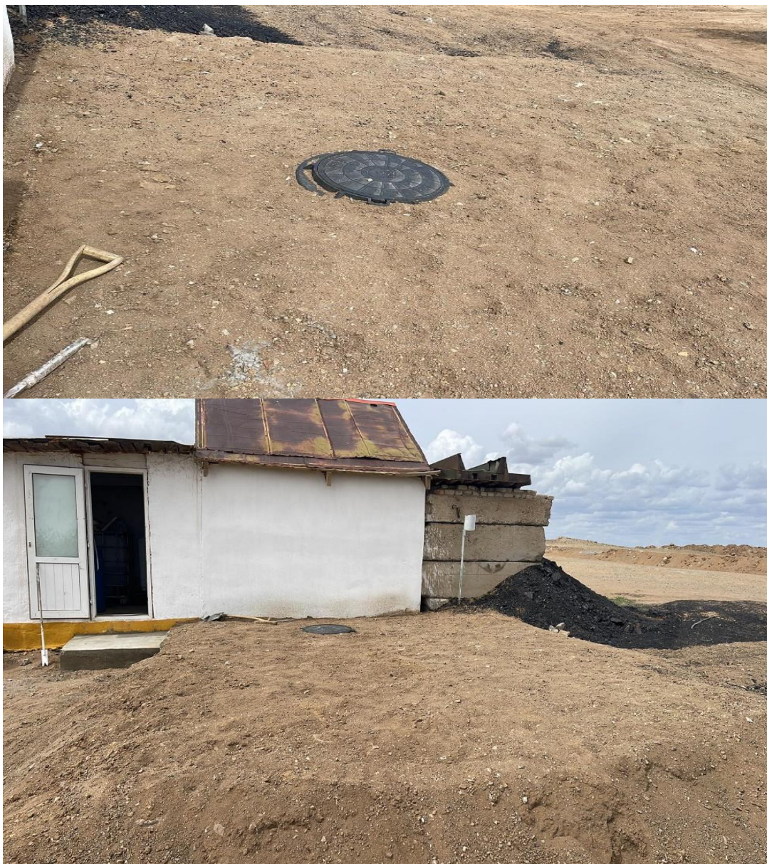
Зураг 24. Ажилчдын ахуйн шингэн хог хаягдлыг битүүмжлэл сайтай дахин соруулах боломжтой болгож засаж тохижуулсан байдал
