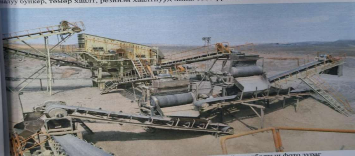
Зураг 6. Баяжуулах үйлдвэрийн тоног төхөөрөмжийн холболтын фото зураг
