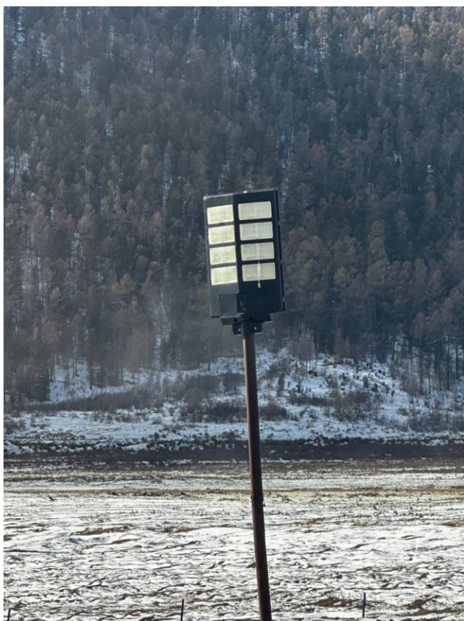
Зураг 7. Уурхайн зарим байршилд нарны эрчим хүчээр цэнэглэгддэг гадна гэрэл байршуулсан.
