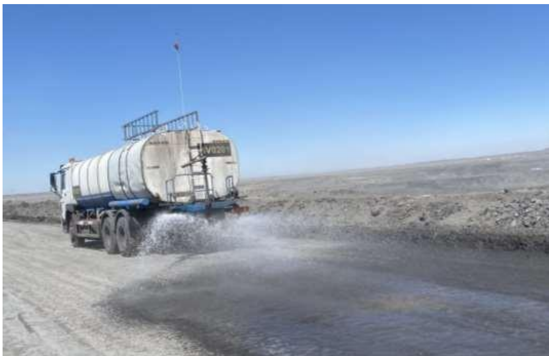
Зураг 24. Зам талбайн тоос дарах усалгаа хийж буй байдал
