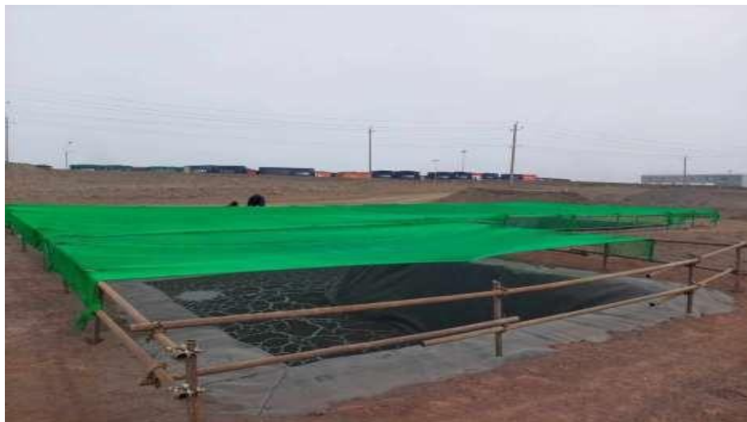
Зураг 30. Өрөмдлөгийн нүхэнд шувуу орохоос хамгаалсан тор хийсэн байдал
