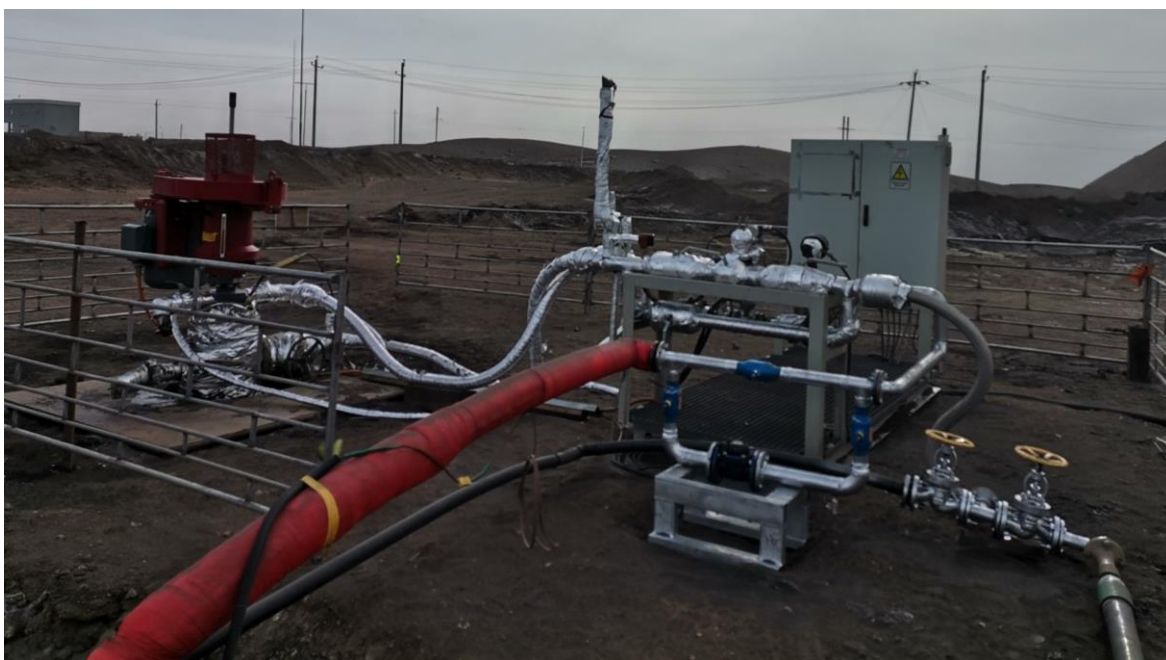
Зураг 46. LF_06 цооног орчны зураг болон тоолуур суурьдуулсан байдал
