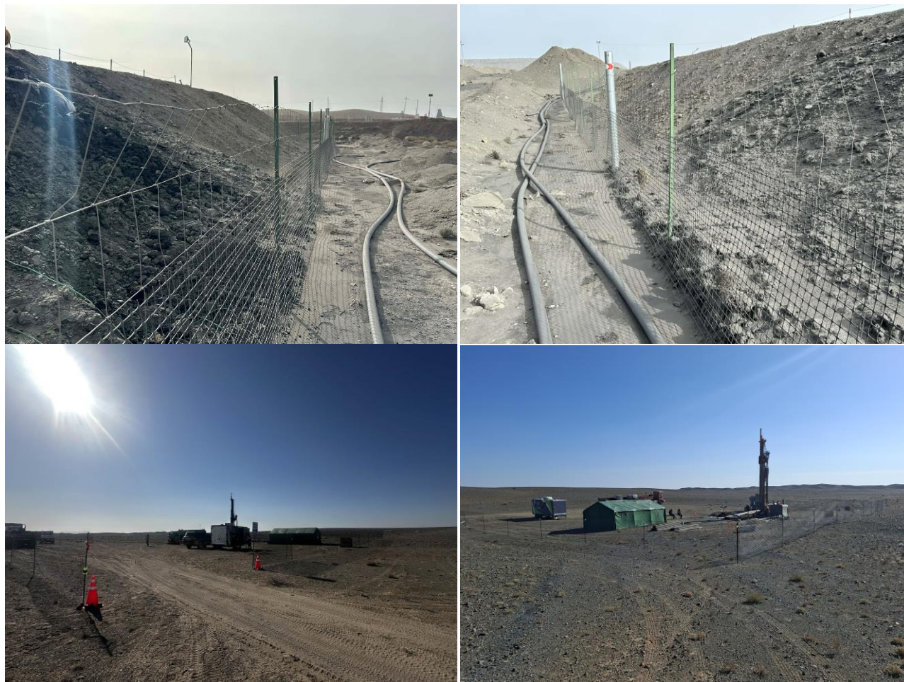
Зураг 49. Жижиг торон хашааг суурьлуулсан байдал
