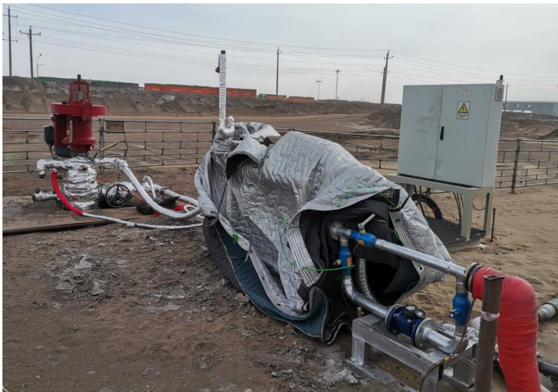
Зураг 45. LF_04 цооног орчны зураг болон тоолуур туурьлуулсан байдал
