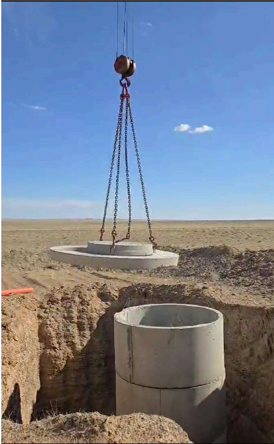
Зураг. Уурхайн ажилчдын бие засах газрын суурь болон нүхийг бетондсон байдал
