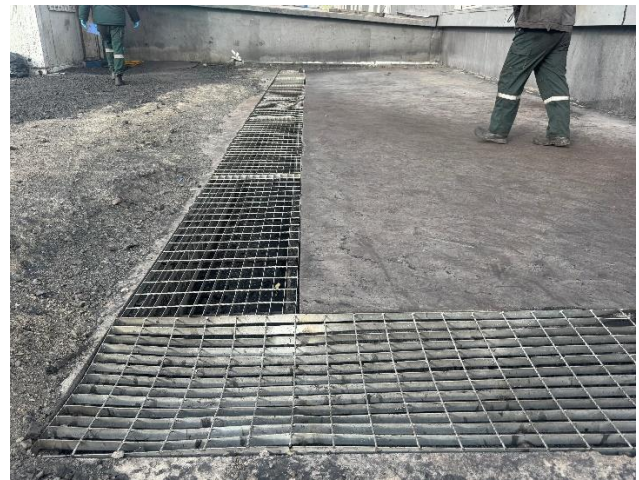
Зураг 26. Барилга байгууламжийн ус зайлуулах суваг шуудууны байгууламж
