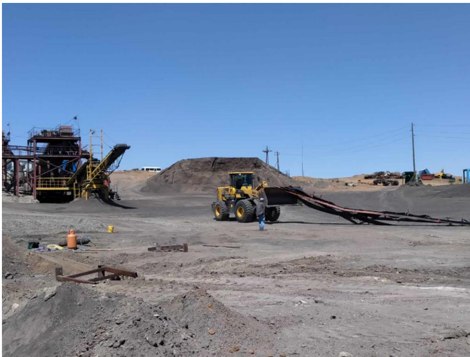
Зураг.10. Илүү ашиглалт явуулсан газраас тоног төхөөрөмж шилжүүлж буй зураг
