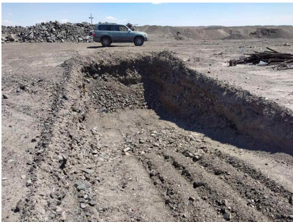
Зураг.13. Илүү ашиглалт явуулсан газраас тоног төхөөрөмж шилжүүлж буй зураг,
