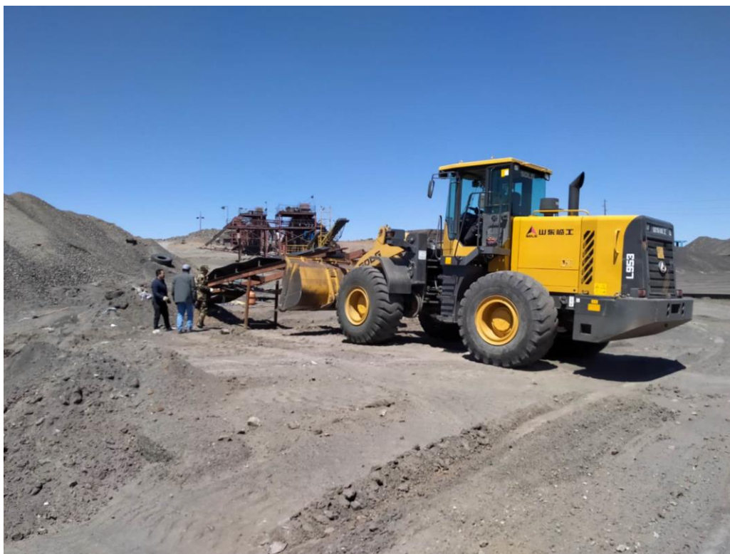
Зураг.12. Илүү ашиглалт явуулсан газраас тоног төхөөрөмж шилжүүлж буй зураг,
