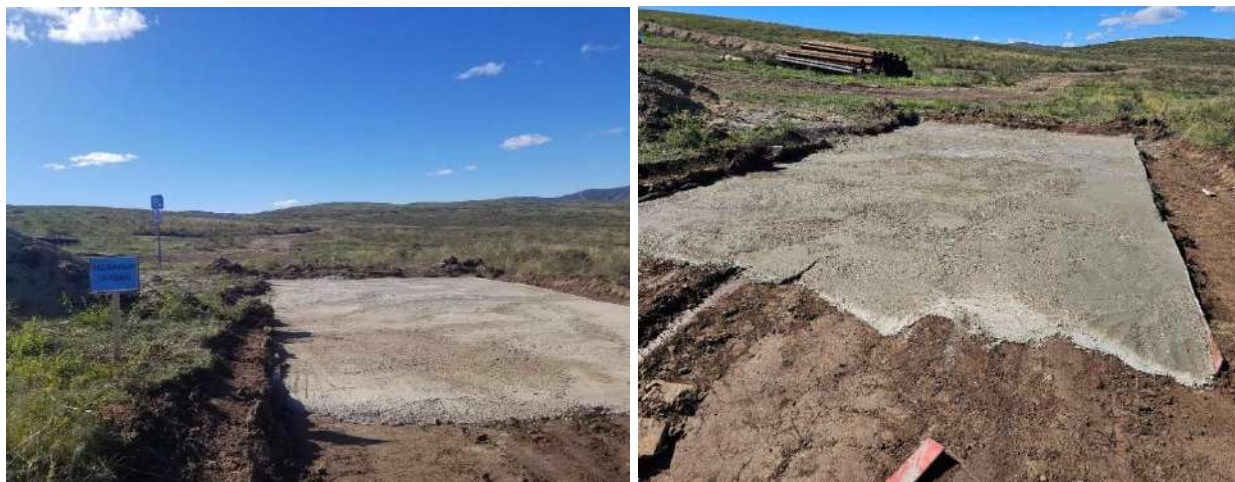
Зураг-1.. Засварын талбайг хатуу хучилттай болгосон байдал
