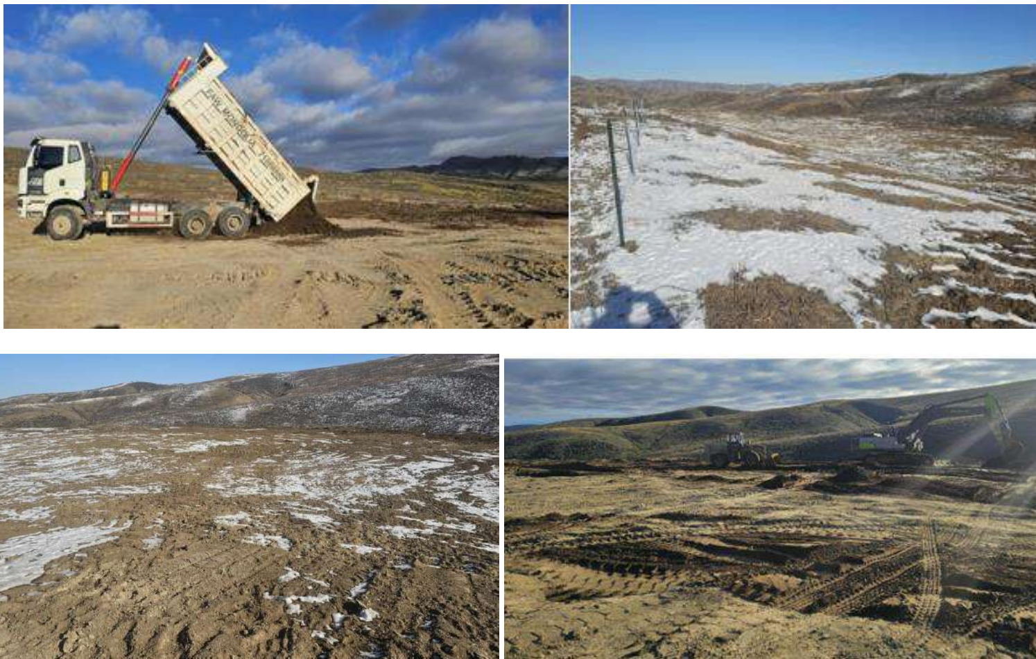
Зураг 13. Шимт хөрсийг зөөвөрлөж асгаж буй байдал болон шимт хөрсийг тарааж үр тарьсаны дараах
