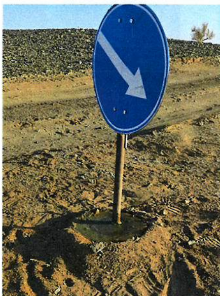
Тэмдэгийн суурийг бетон цутгаж хийсэн.
