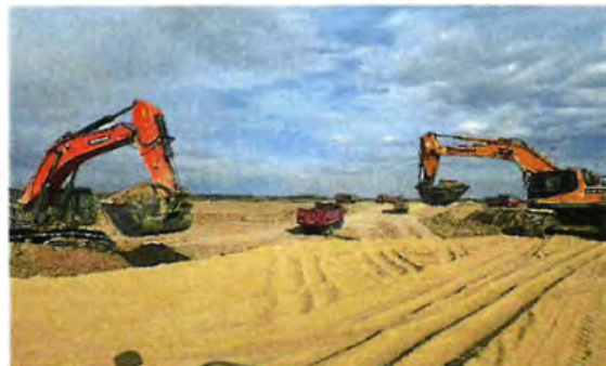
Дүүргэлтийн материал зөвөрлөж байгаа байдал
