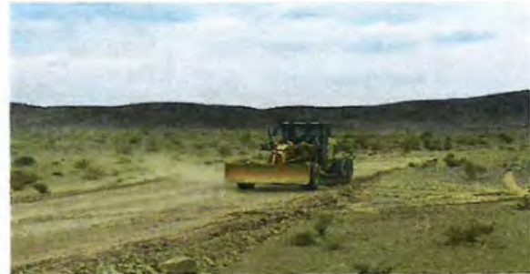
Дүүргэлтийн материал зөвөрлөж байгаа байдал
