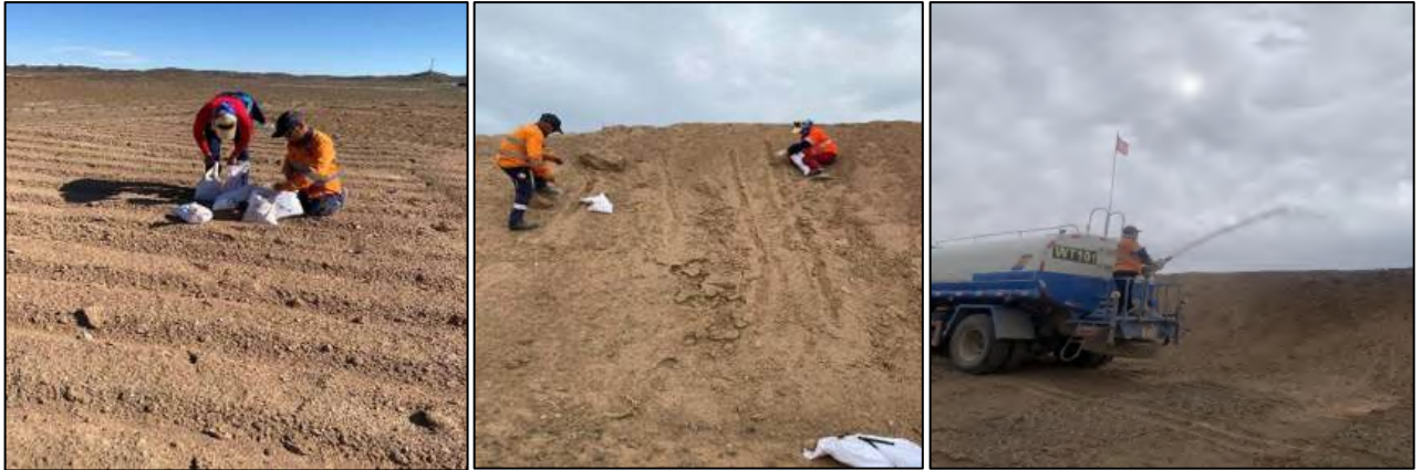
Зураг 23. Шимт хөрсний овоолгын арчилгаа
