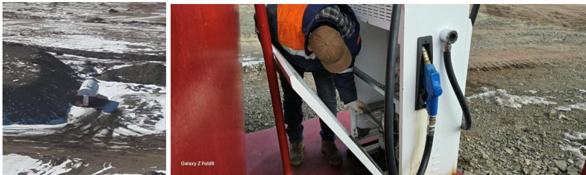
Зураг 6 ШТСтанцад үзлэг хийж байгаа нь
