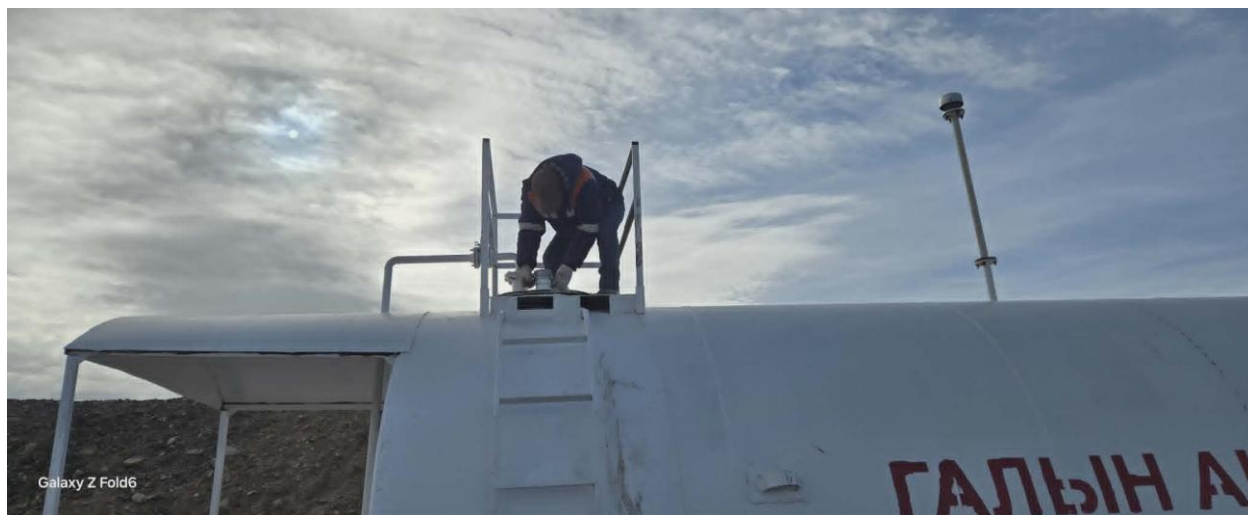
Зураг 6 ШТСтанцад үзлэг хийж байгаа нь
