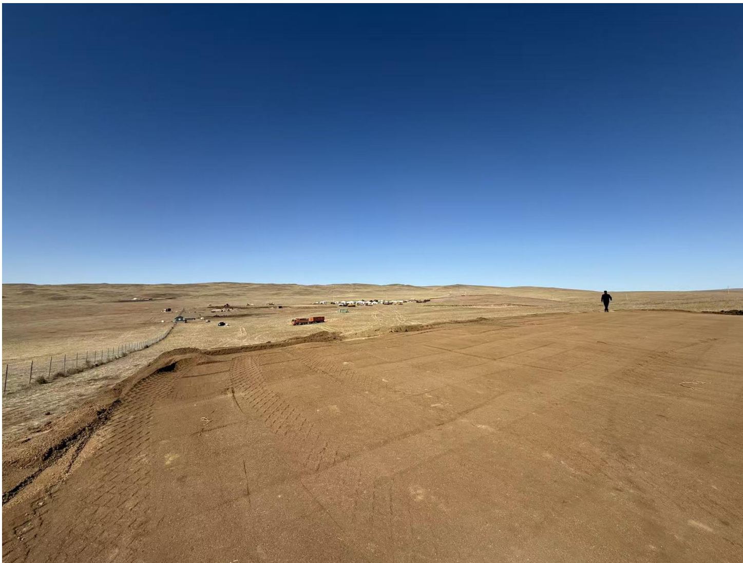
Зураг 9. Үйлдвэрийн талбайн шимт хөрсийг хуулсан байдал
