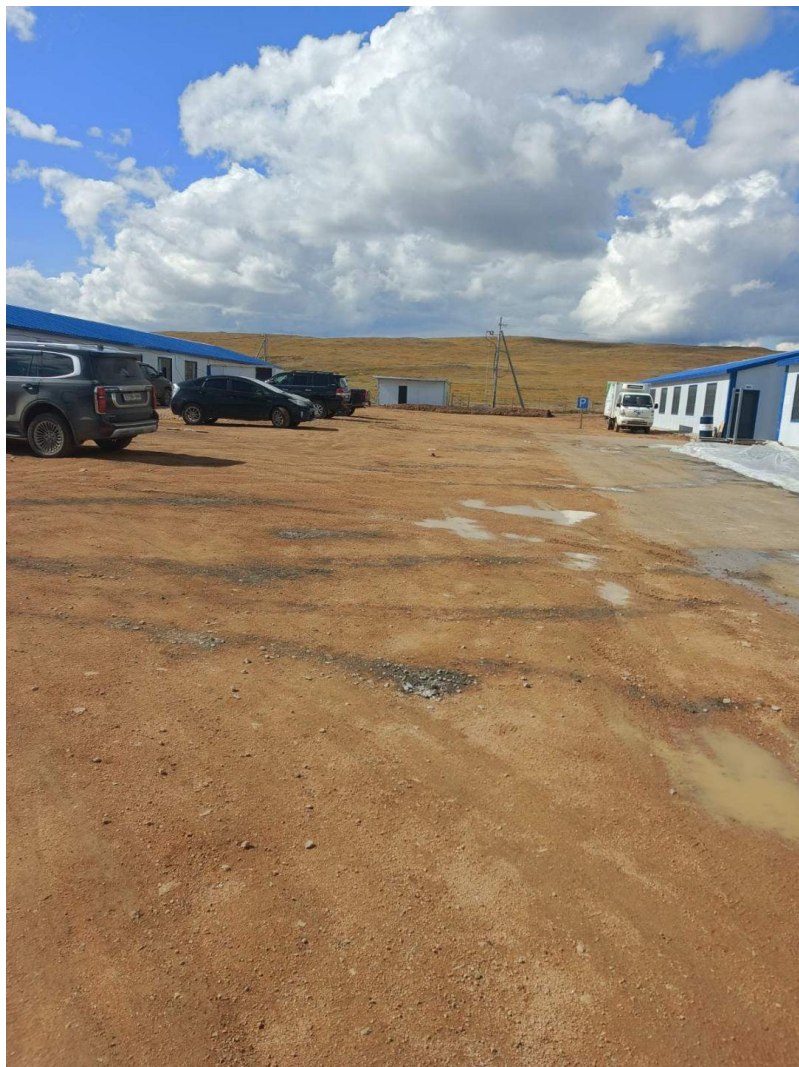
Зураг 4. Уурхайн дотоод тээврийн зам байгуулж, тэмдэгжүүлж, усалсан байдал
