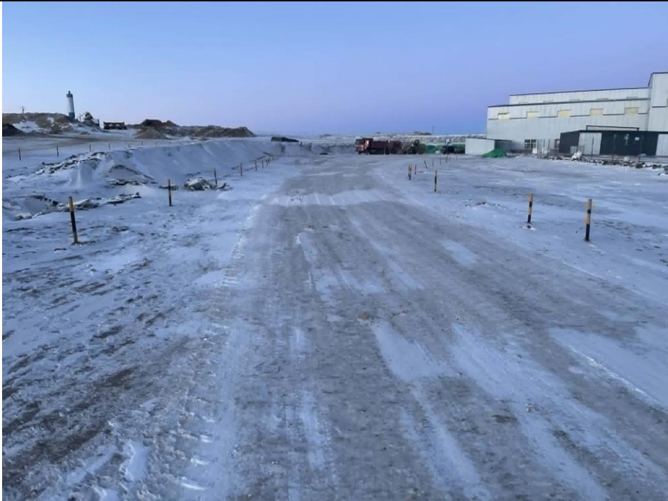
Зураг 2. Үйлдвэрийн талбай дотор тавьсан дотоод тээврийн сайжруулсан шороон зам
