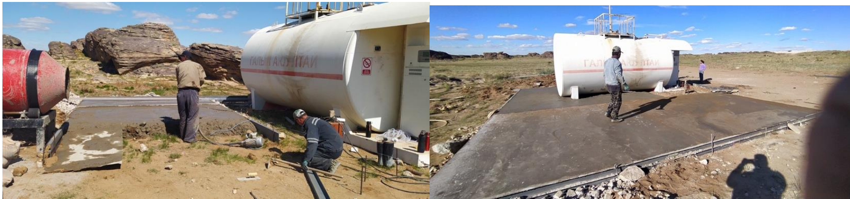
Зураг 5. ШТС-ын суурийг цементлэв /05 сарын 26/
