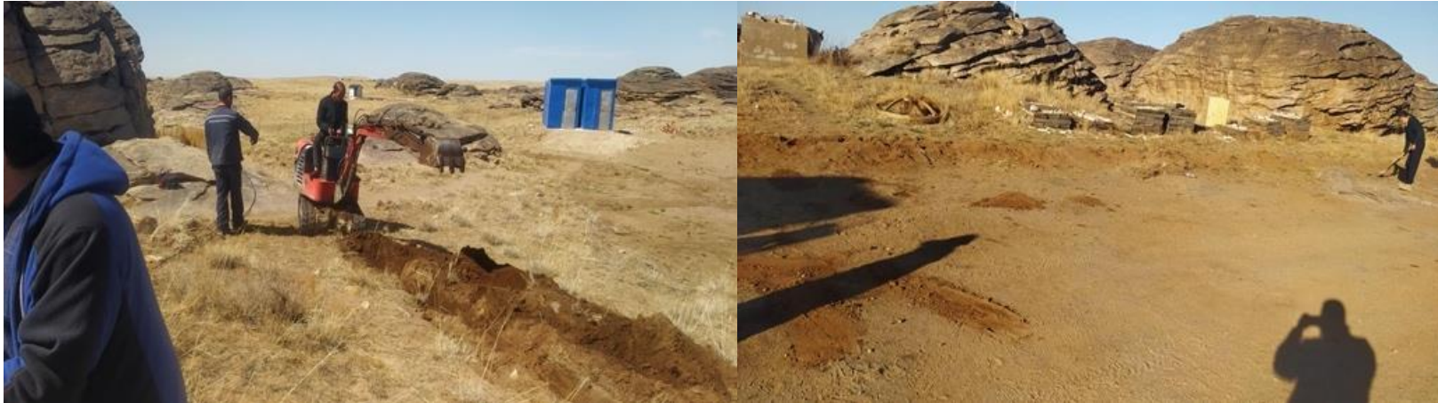
Зураг 22. Үерийн усны далангийн засвар шинэчлэлийн ажил
