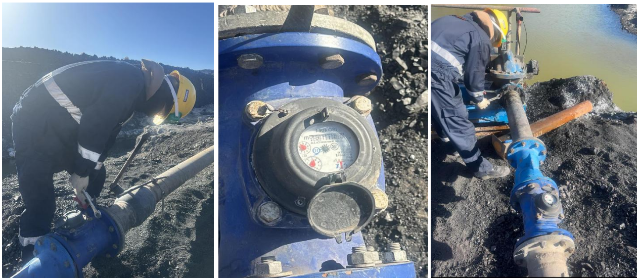
Зураг 3. Шүүрлийн усны насост тоолуур суурьлуулж байгаа нь
