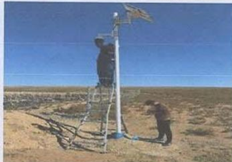
Зураг 2. Самбар суурилуулж, камерын хяналтын холболт хийж байгаа нь
