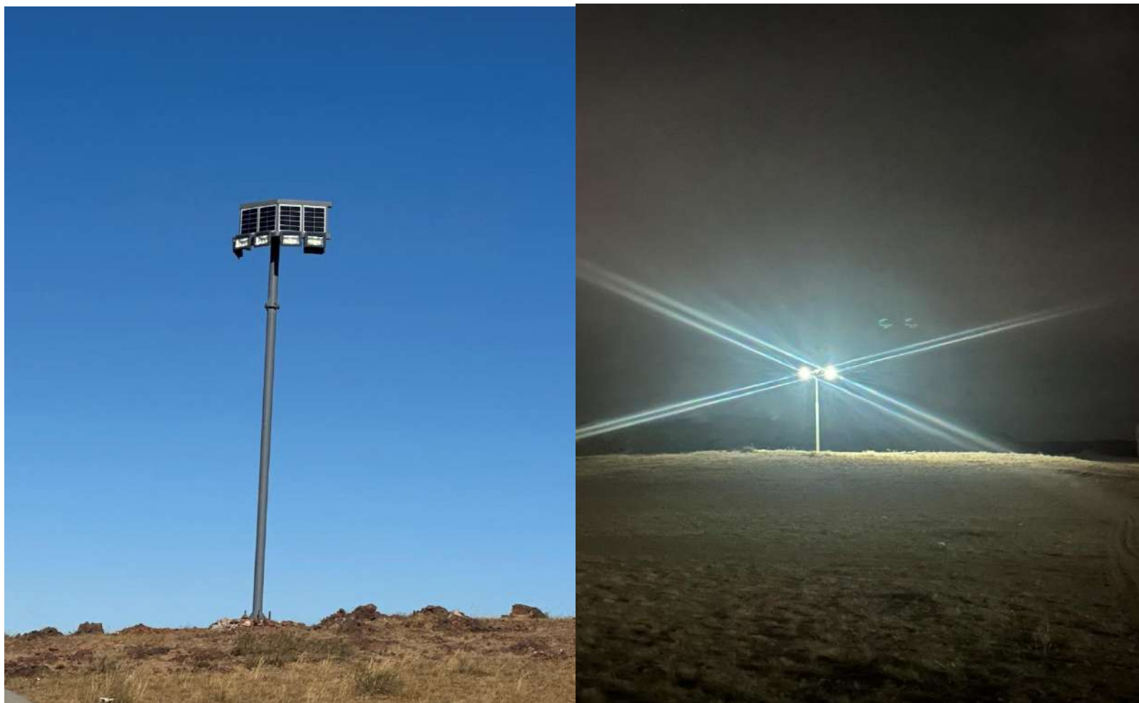
Зураг 23. Уурхайн тосгон, явган хүний зам, ШТС, Засварын шонд нарны зайн мэдрэгчтэй гэрэл суурилуулсан. Мөн уурхайн үйл ажиллагааг аюулгүйгээр явуулах нөхцөлийг хангахад гарцаагүй шаардлагатай гэрэлт цамхгийг суурилуулсан байдал
