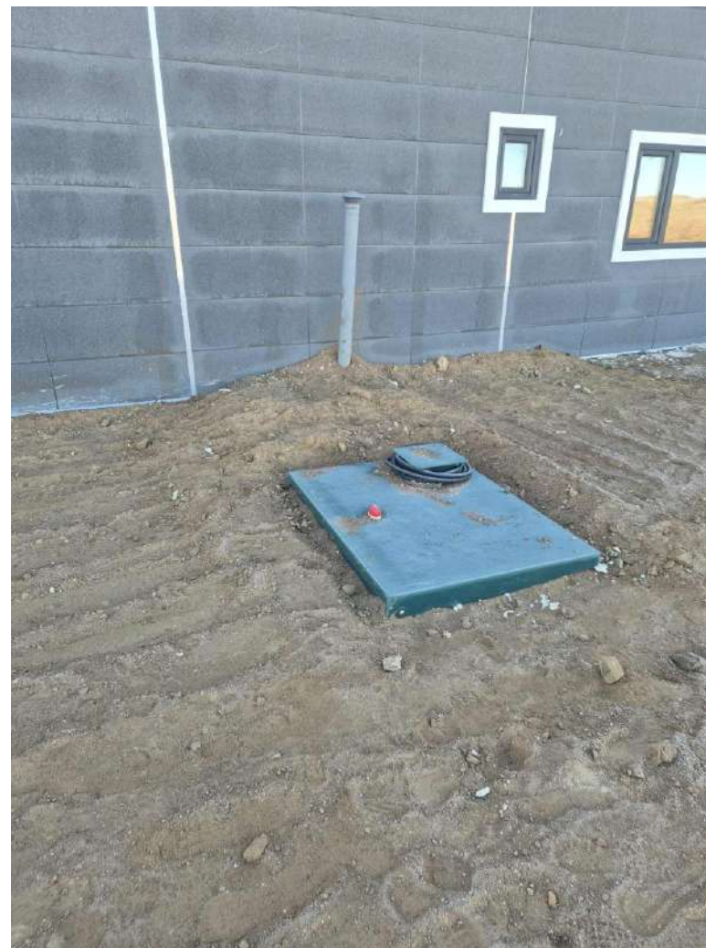
Зураг 12. Уурхайн хотхон, оффис, гал тогооны барилга байгууламжийн бохир усыг 98 хувь цэвэрлэх Алтай эколос ХХК-ийн Биолос иж бүрэн цэвэрлэх байгууламж суурилуулсан байдал
