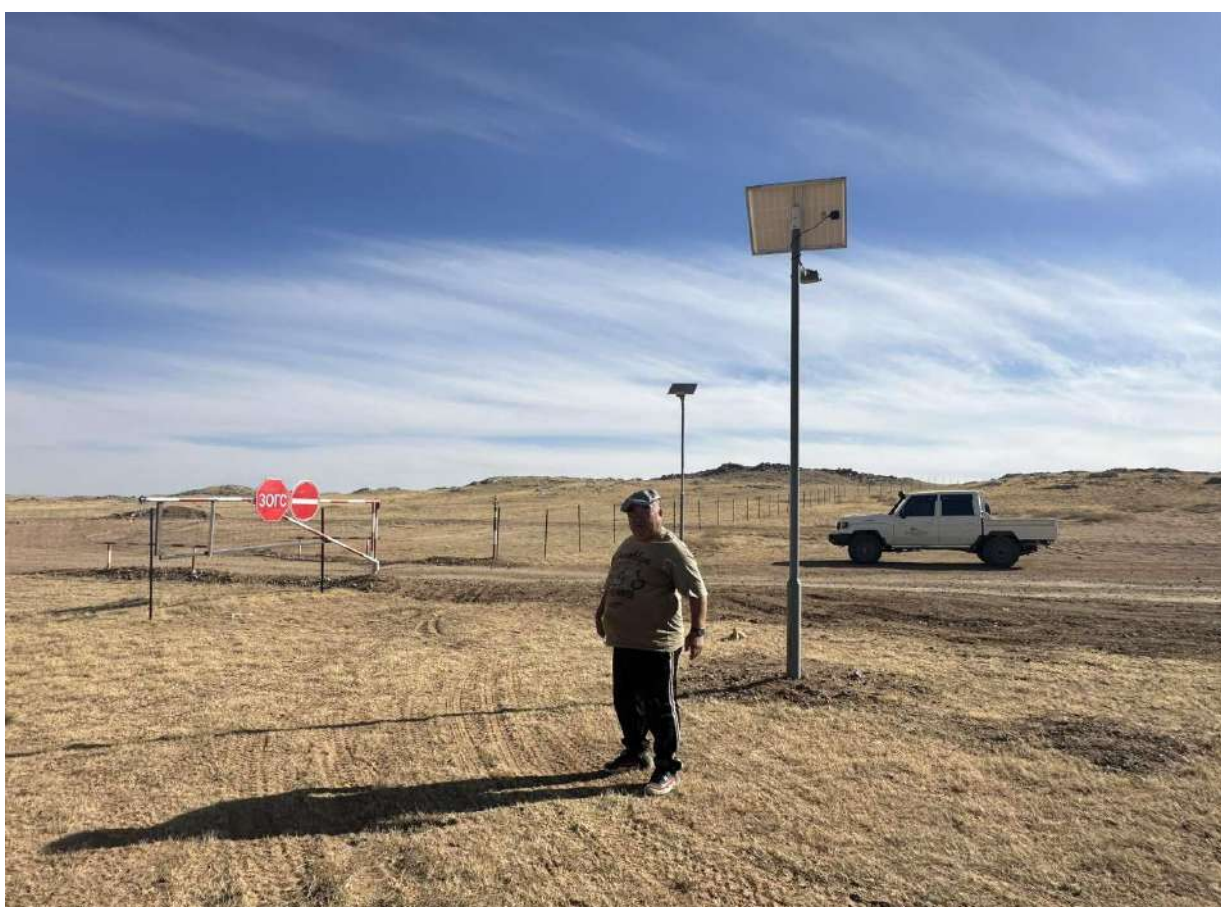
Зураг 27. Нарны зайн хураагууртай ажилладаг гудамж, талбайн гэрэлтүүлэг болон хяналтын камер
