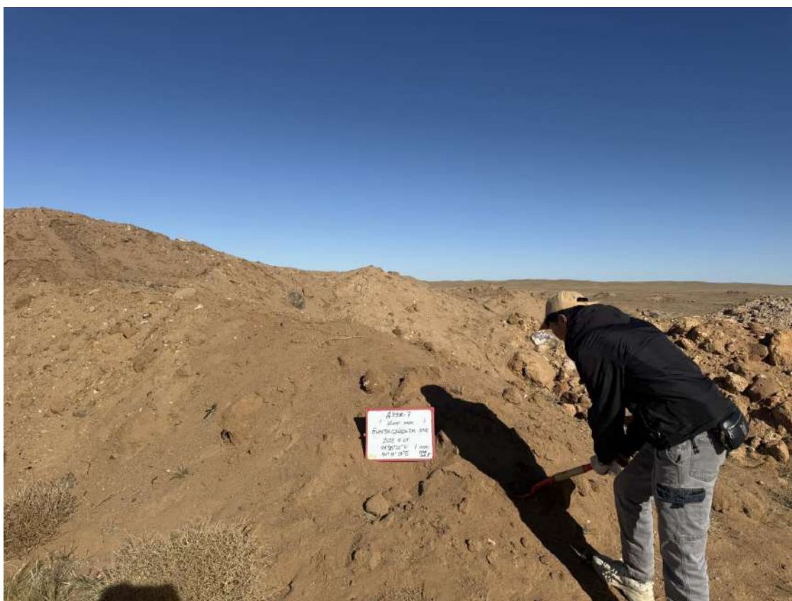
Зураг 30. Төслийн үйл ажиллагаанаас шууд нөлөөлөлд өртөх газрын гадаргын шимт хөрсийг хуулж, MNS 5916:2008 стандартын дагуу хадгалах, хөрсний овоолгыг MNS 5917:2008 стандартын шаардлагын дагуу налуулан овоолгыг үүсгэж хяналтын дээж авч буй байдал
