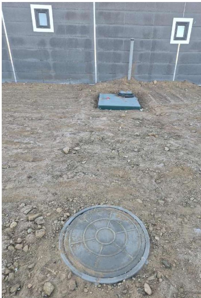
Зураг 12. Уурхайн хотхон, оффис, гал тогооны барилга байгууламжийн бохир усыг 98 хувь цэвэрлэх Алтай эколос ХХК-ийн Биолос иж бүрэн цэвэрлэх байгууламж суурилуулсан байдал
