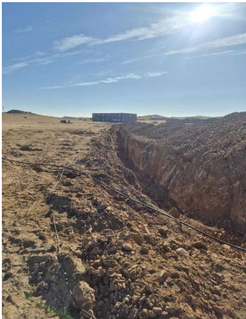
Зураг 17. Гүний худаг өрөмдмөл худгаас цэвэр усны шугам хоолой шинэ шугам хоолой уурхайн хотхон ы барилга уруу татах ажил явагдаж буй байдал
