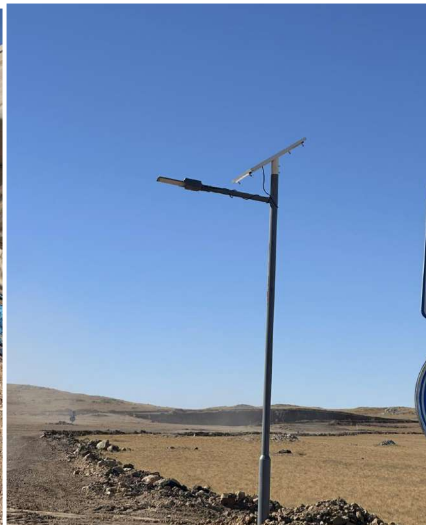
Зураг 24. Нарны зайн хураагууртай ажилладаг гудамж, талбайн гэрэлтүүлэг. Уурхайн түр тосгонд тог гаргагч нарны зайн хураагуур ашиглаж буй байдал
