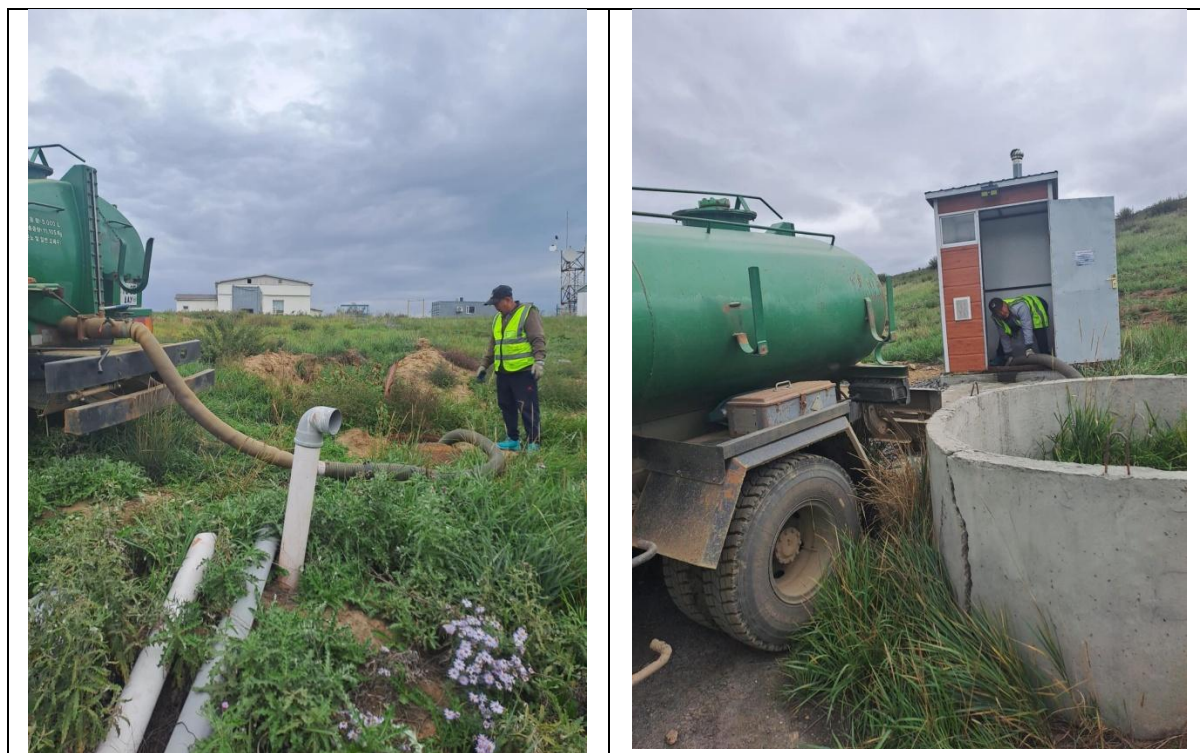
Зураг 7 Бохир ус соруулж буй байдал
