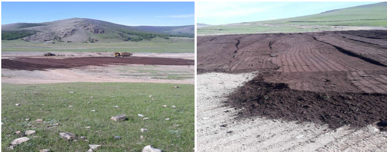
Зураг № 17. Шимт хөрсийг тарааж хөрсжүүлж байгаа байдал
