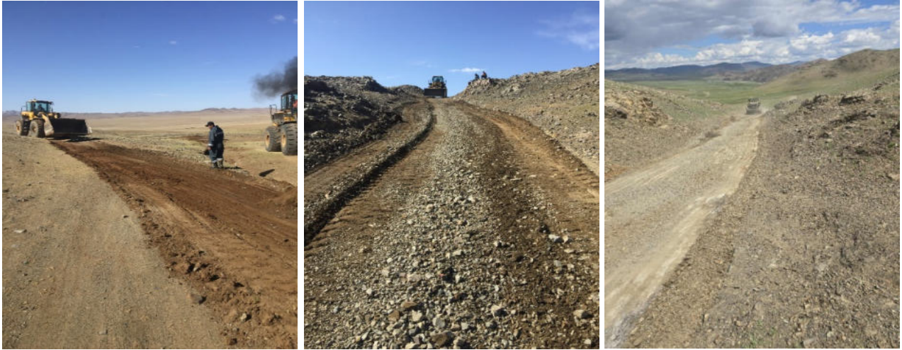
Зураг № 48. Зам даваа засаж, янзлаж байгаа байдал
