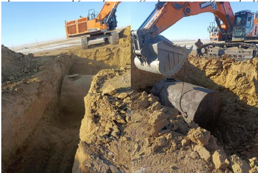
Зураг 1. Бохир хуримтлуулах 25 тн багтаамжтай танк суурилуулсан байдал.
