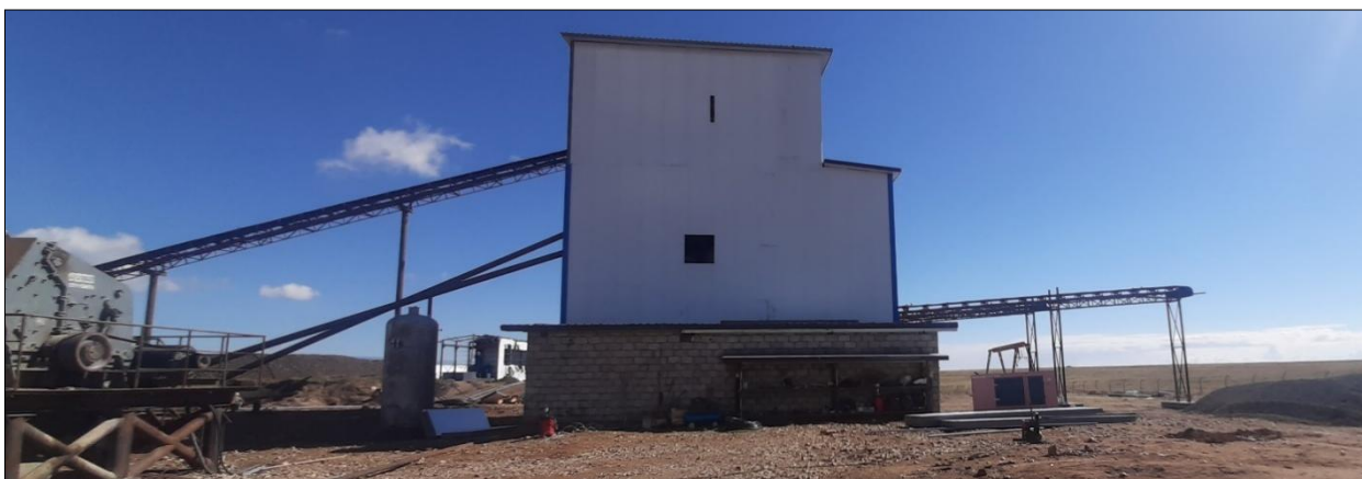
Зураг 4. Баяжуулах үйлдвэрийн барилга
