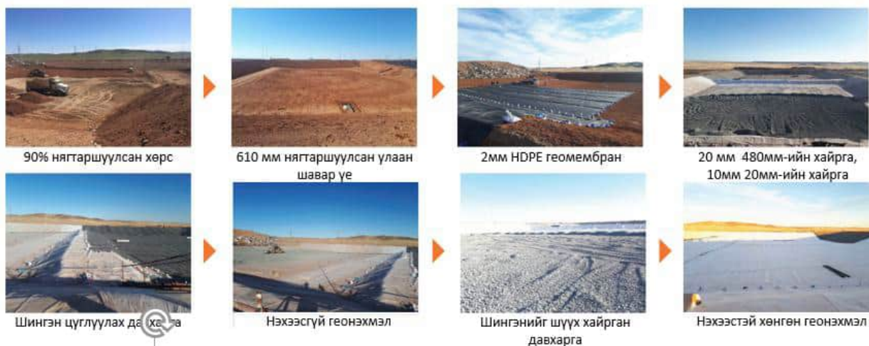
Зураг 13. Хог хаягдал булилах байгууламжийн суурь үеүүд
