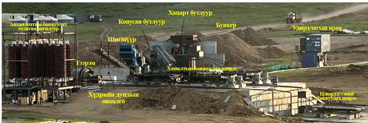
Зураг №5. Баяжуулах үйлдвэрийн харагдах байдал
