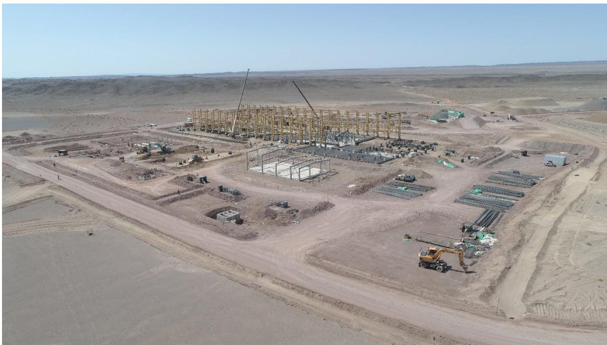
Зураг 14. Баяжуулах үйлдвэрийн барилгын явц
