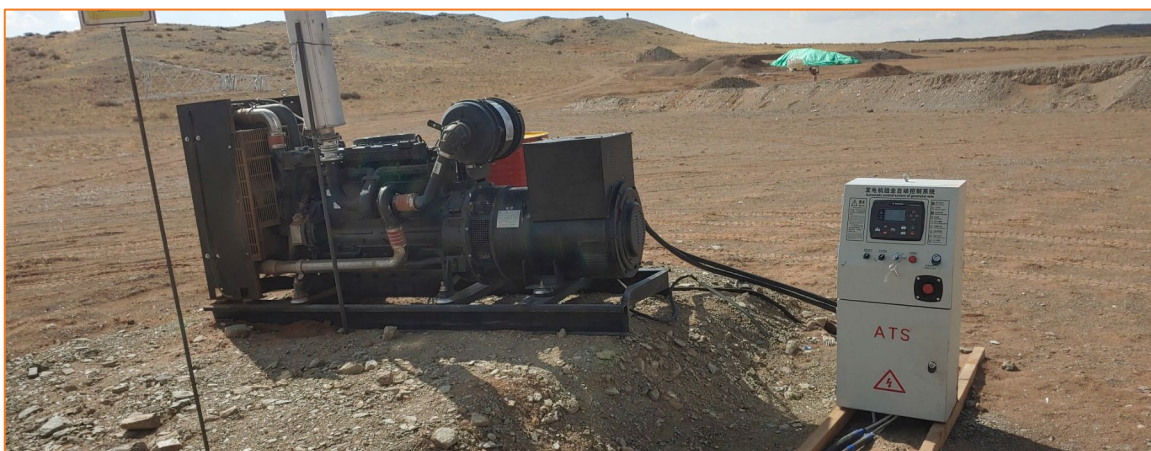
Зураг 6. Уурхайн талбайд бүтээн байгуулалтад ашиглаж буй генератор
