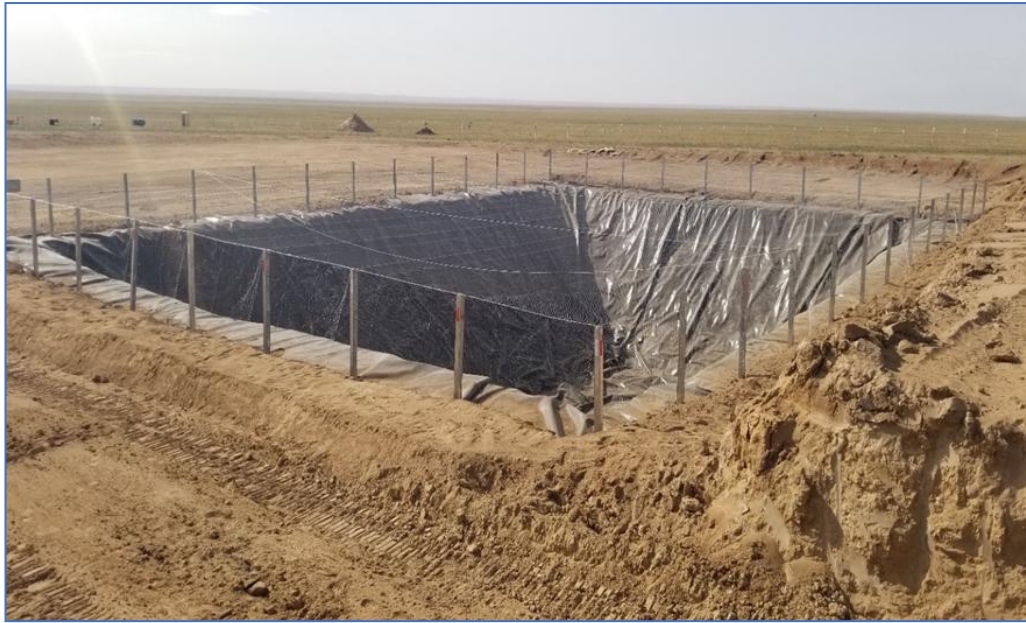
Зураг 1. 7. Өрөмдлөгийн шингэн хаягдлын санг бэлтгэх байдал
