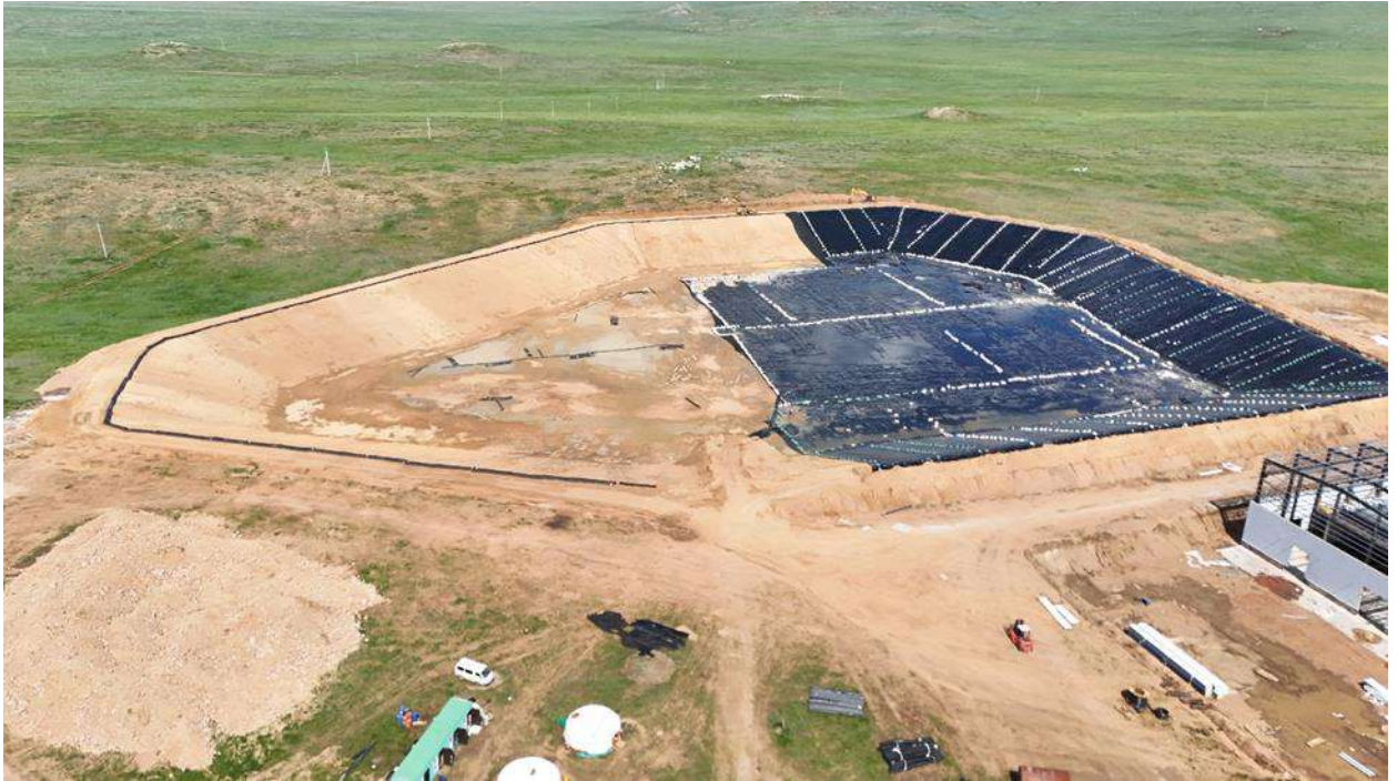
Зураг 7. Хаягдал хадгалах байгууламжийн бүтээн байгуулалтын ажил хээрийн судалгааны үед DJI air drone 2025-07-04
