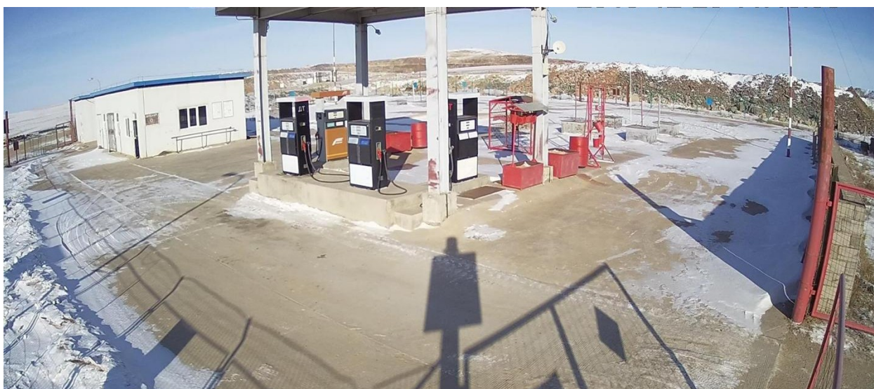
Зураг.3 Шатахуун түгээх станц
