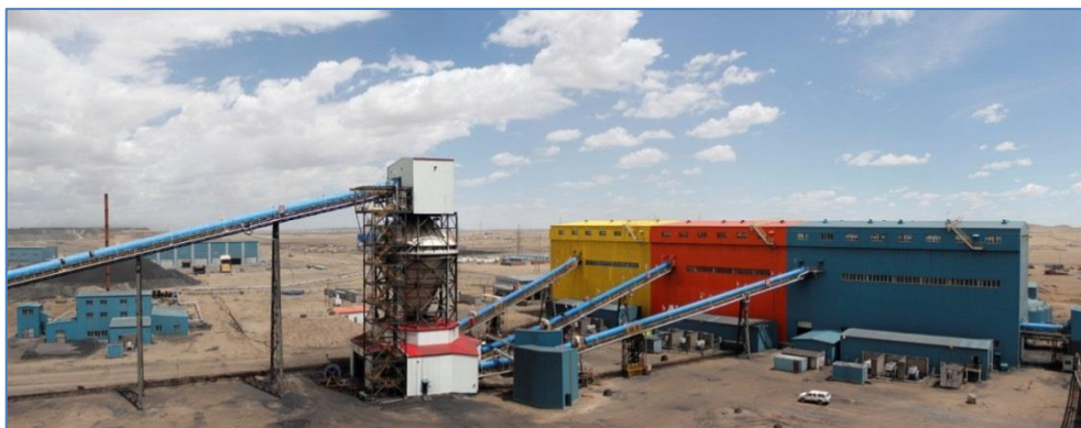
Зураг 1.2. Нүүрс баяжуулах үйлдвэр
