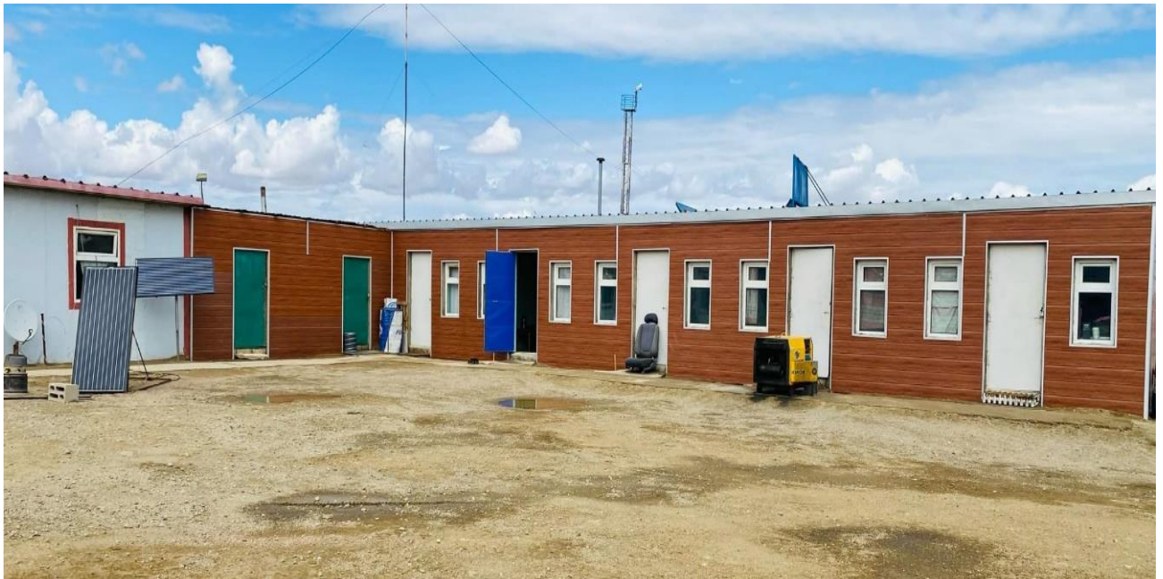
Зураг 5. Шинээр нэмж барьсан сууц
