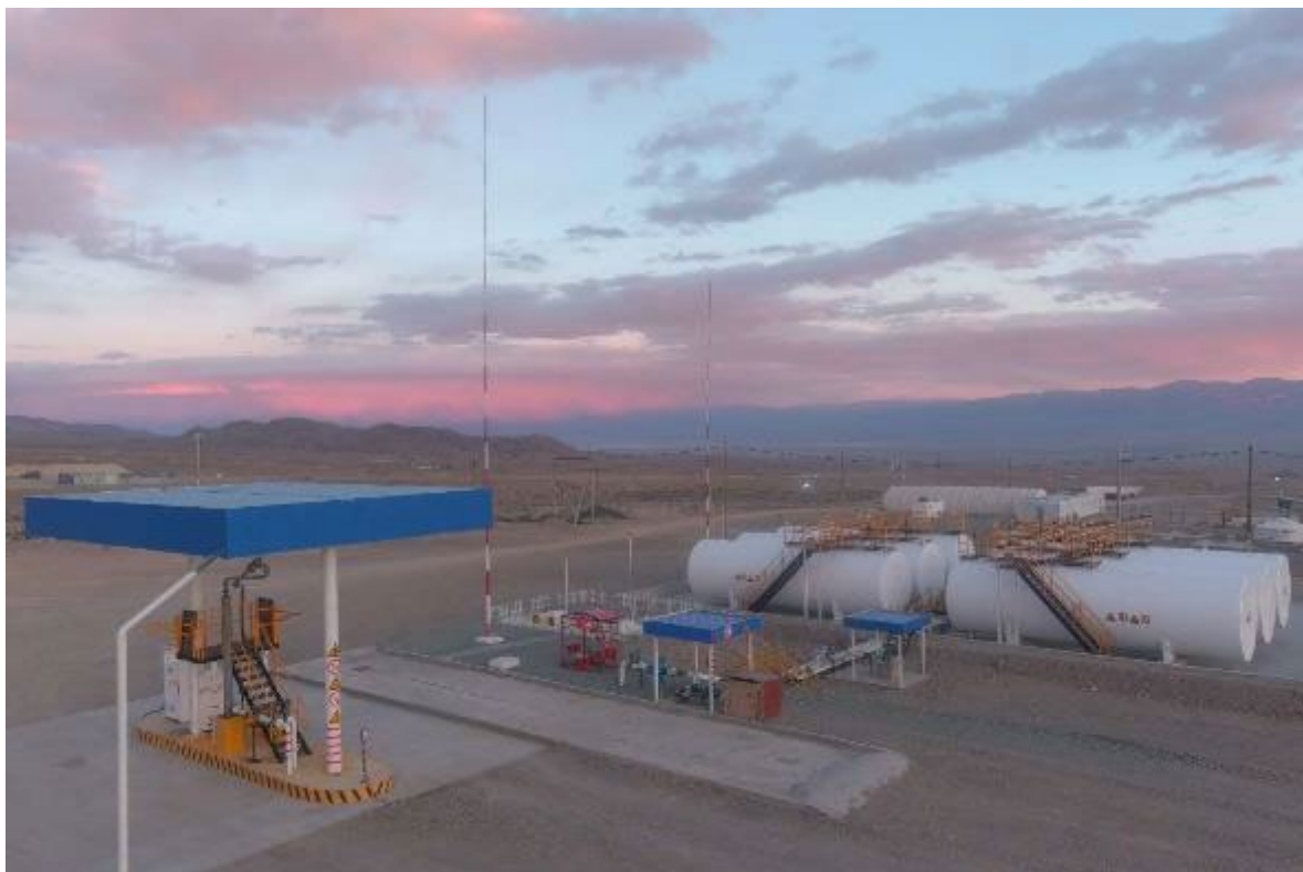
Зураг 15. Шатахуун түгээх станцын угсрагдсан байдал
