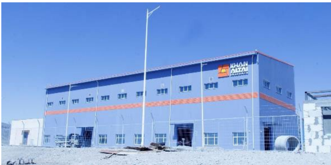
Зураг 7. Үйлдвэрийн цогцолборын ерөнхий харагдах байдал
