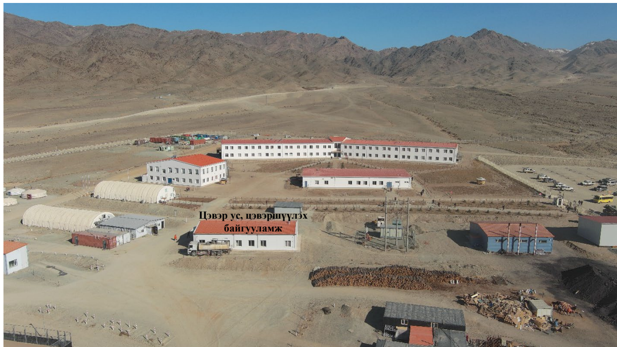
Зураг 22. Цэвэр ус цэвэршүүлэх байгууламж
